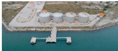
Terminal de Recepção de Produtos Betuminosos
