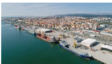
Terminal de Carga Geral
