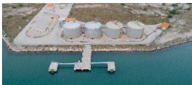
Terminal de Receção de Produtos Betuminosos
